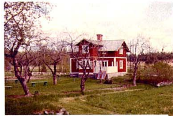
Anderssonsfjällen som det ser ut omkring 1960. Då bodde John och Linnea Andersson där. Kvar 2002 är grunden och altan.
