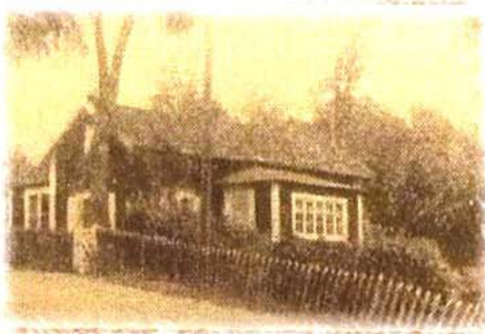
Arenberga 1:5, "Katrineberg". Låg på Stockholmsvägen 55-57
